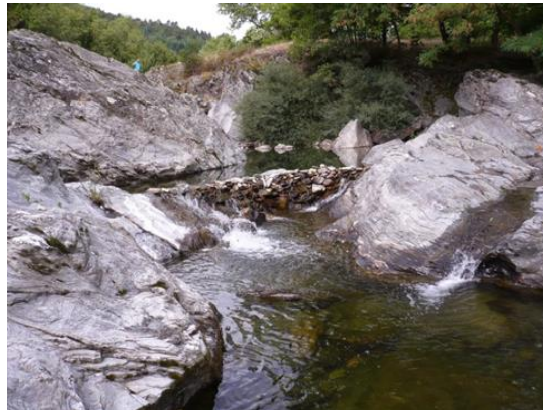
Barrage à la station de Saumanes
